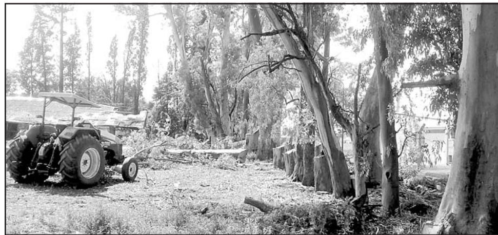
TRABAJOS DE EXTRACCIÓN. Las máquinas quitando los eucaliptos
